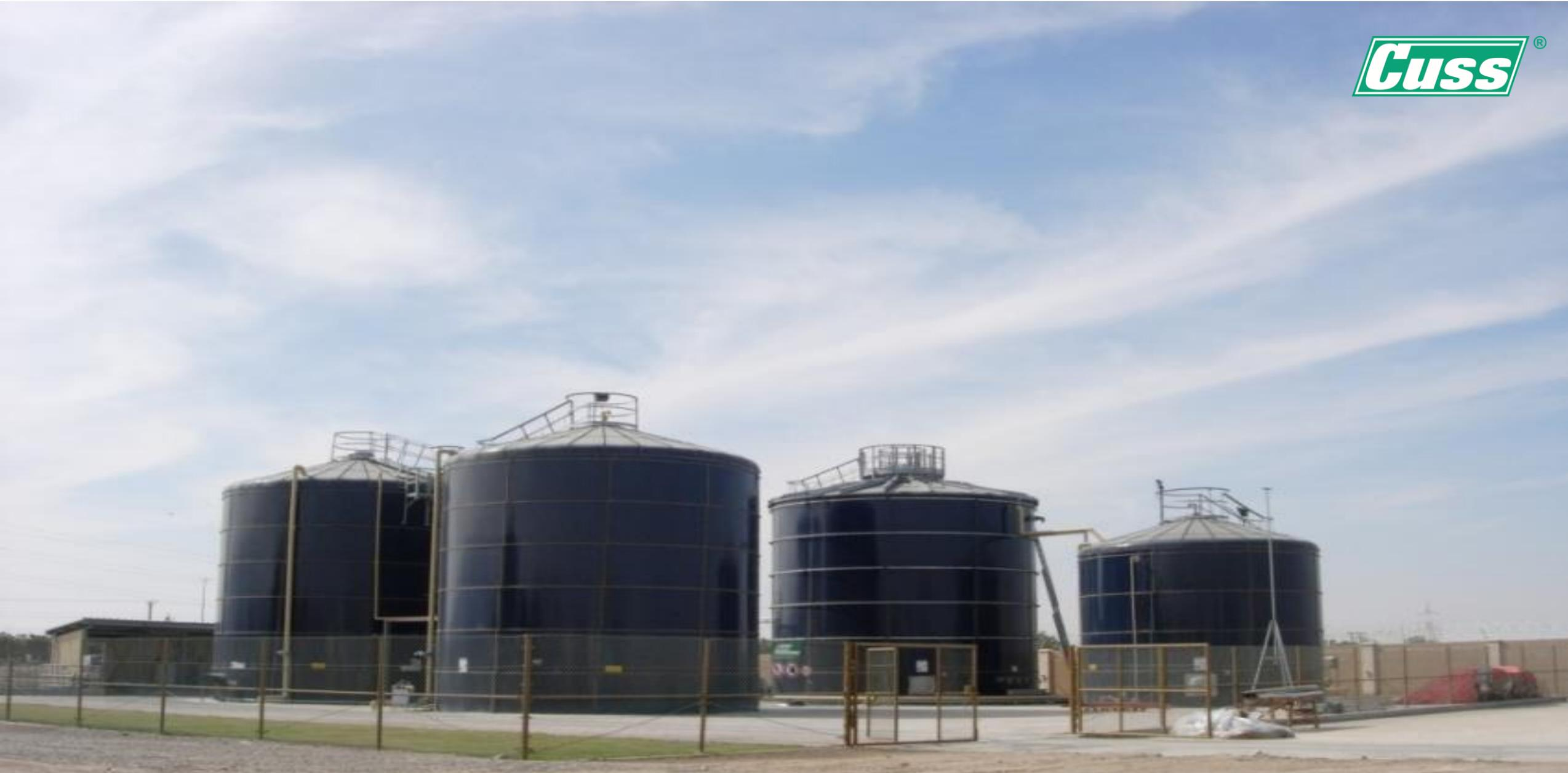
**Tratamiento anaerobio de aguas residuales para una planta de producción de bebidas en UAE, 800 m<sup>3</sup>/d**
