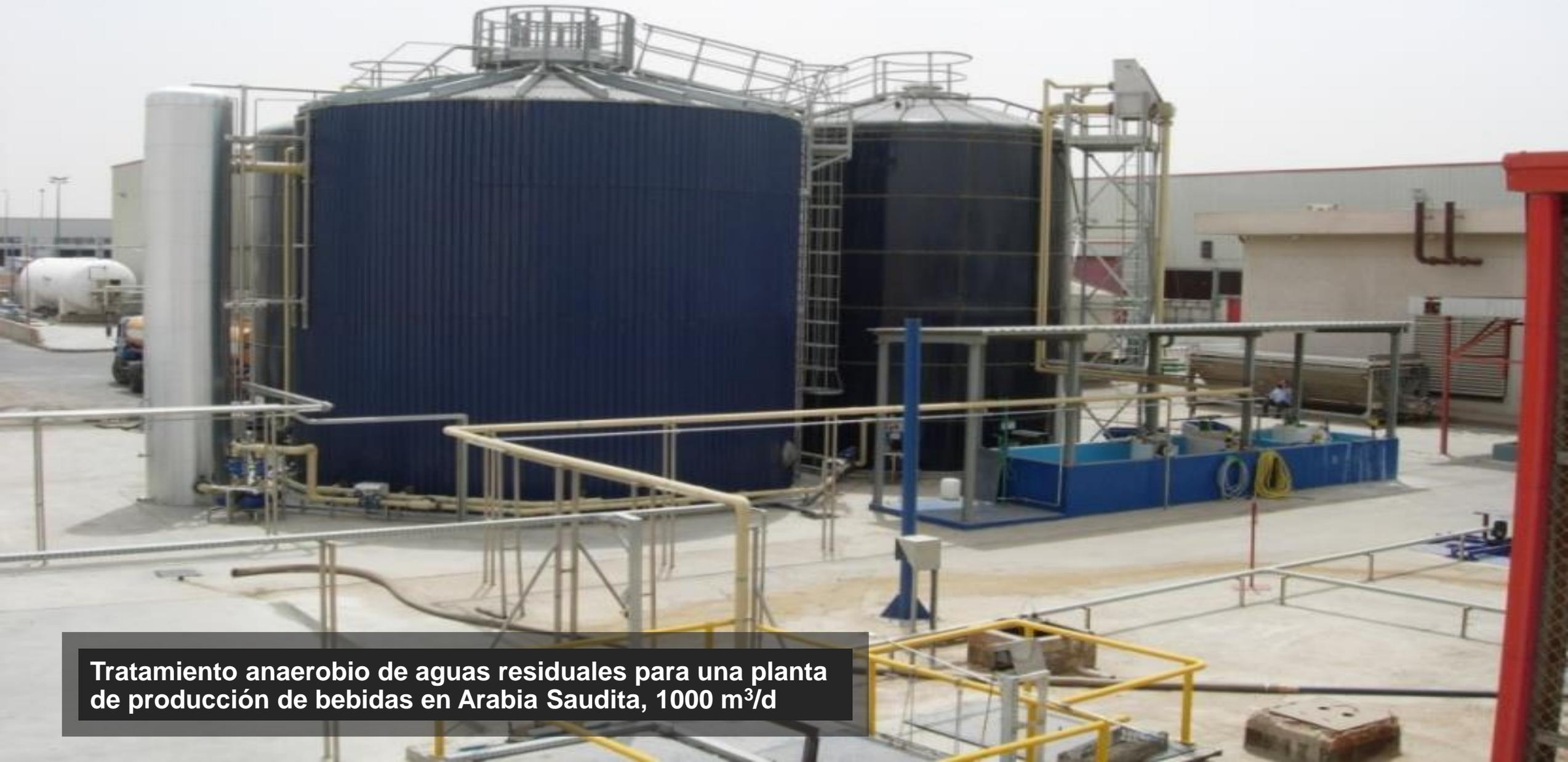
**Tratamiento anaerobio de aguas residuales para una planta de producción de bebidas en Arabia Saudita, 1000 m<sup>3</sup>/d**
