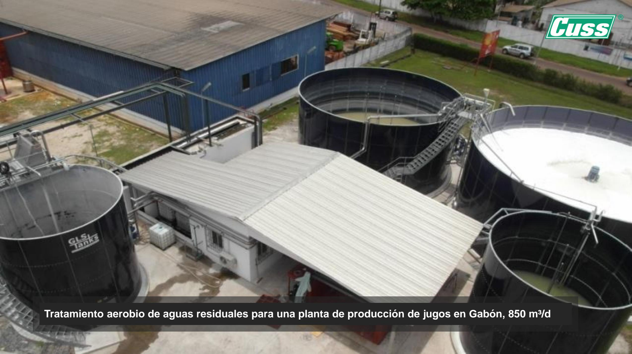
Tratamiento aerobio de aguas residuales para una planta de producción de jugos en Gabón, 850 m<sup>3</sup>/d
