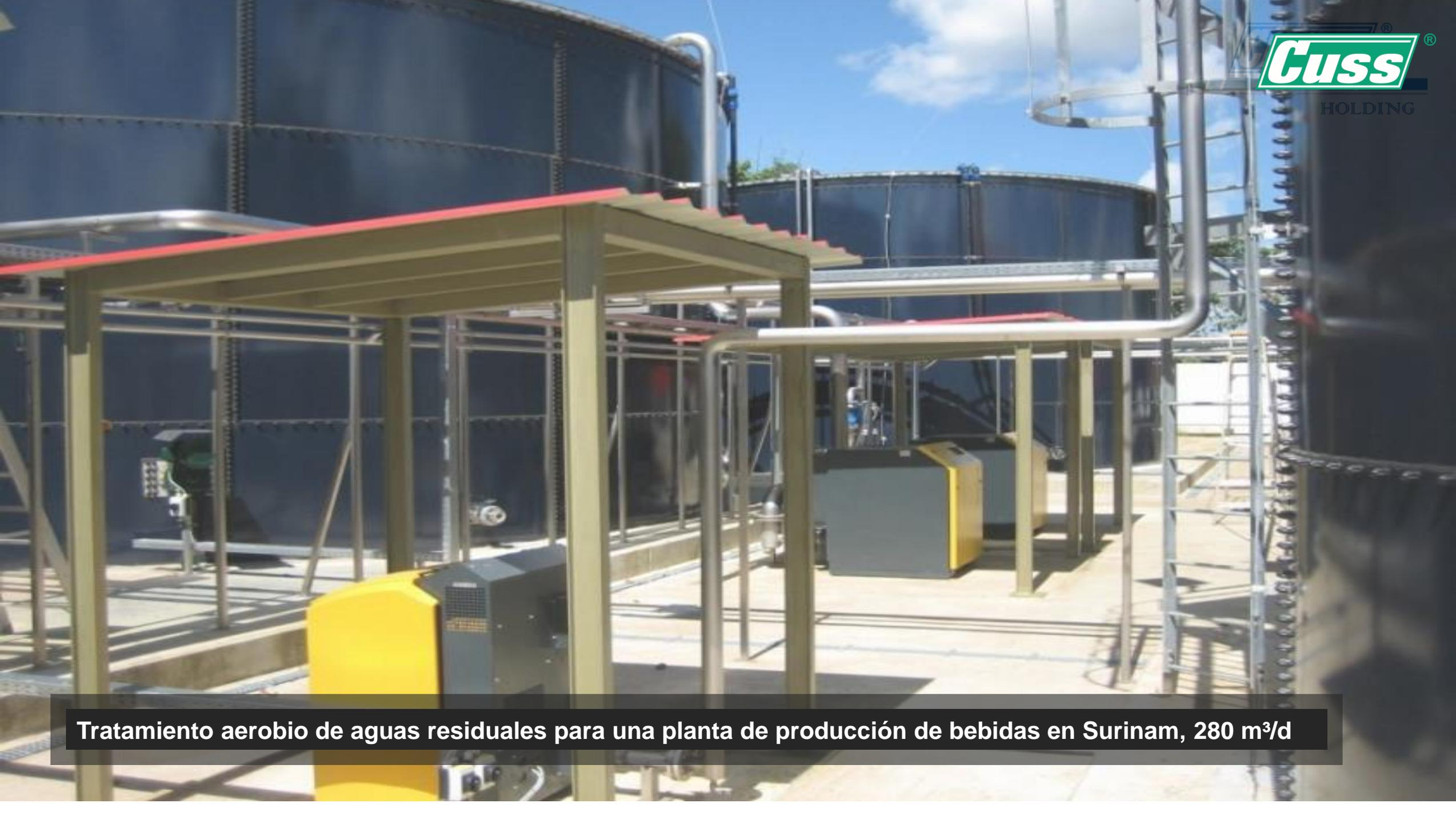
Tratamiento aerobio de aguas residuales para una planta de producción de bebidas en Surinam, 280 m<sup>3</sup>/d
