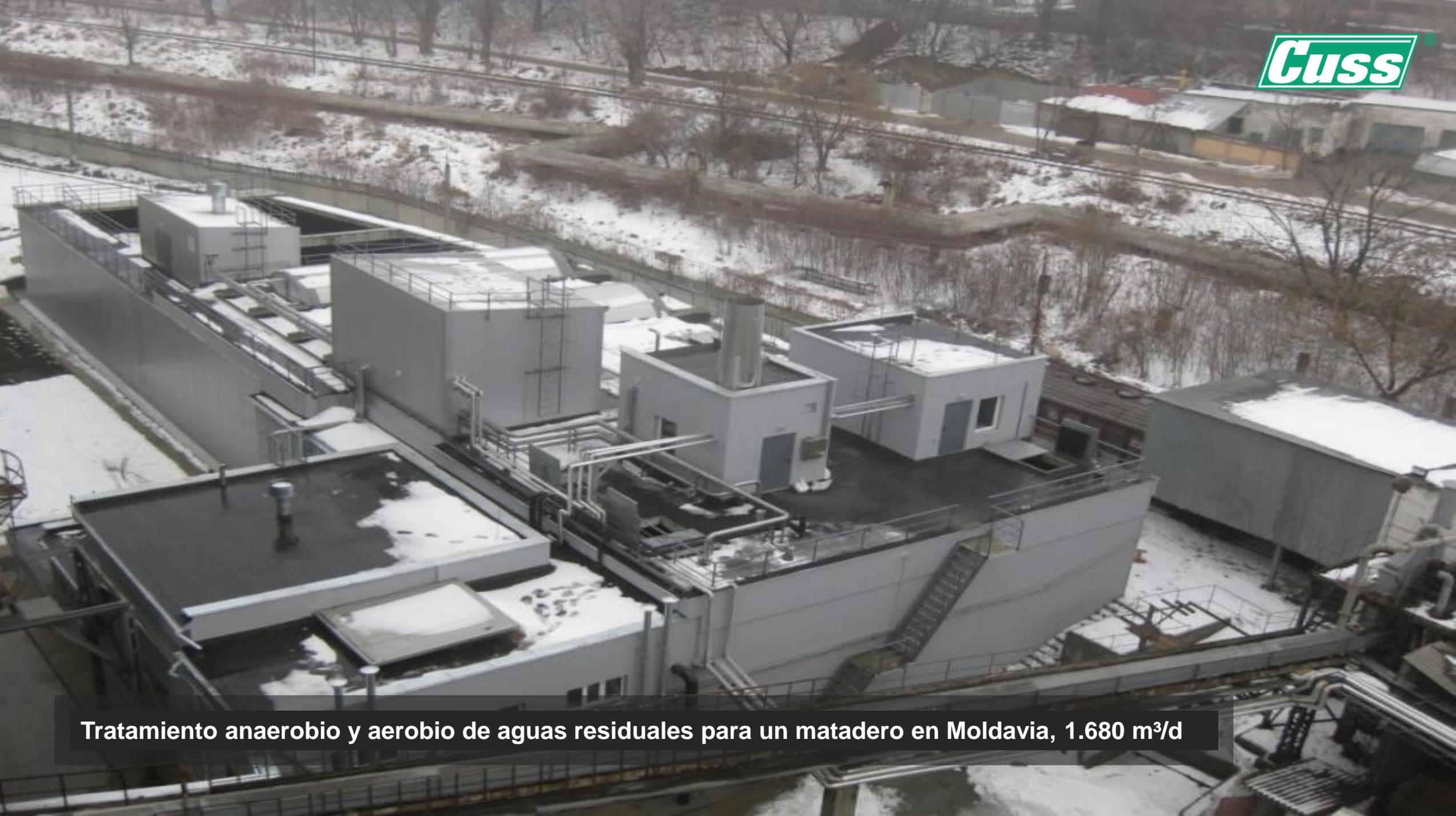
Tratamiento anaerobio y aerobio de aguas residuales para un matadero en Moldavia, 1.680 m<sup>3</sup>/d
